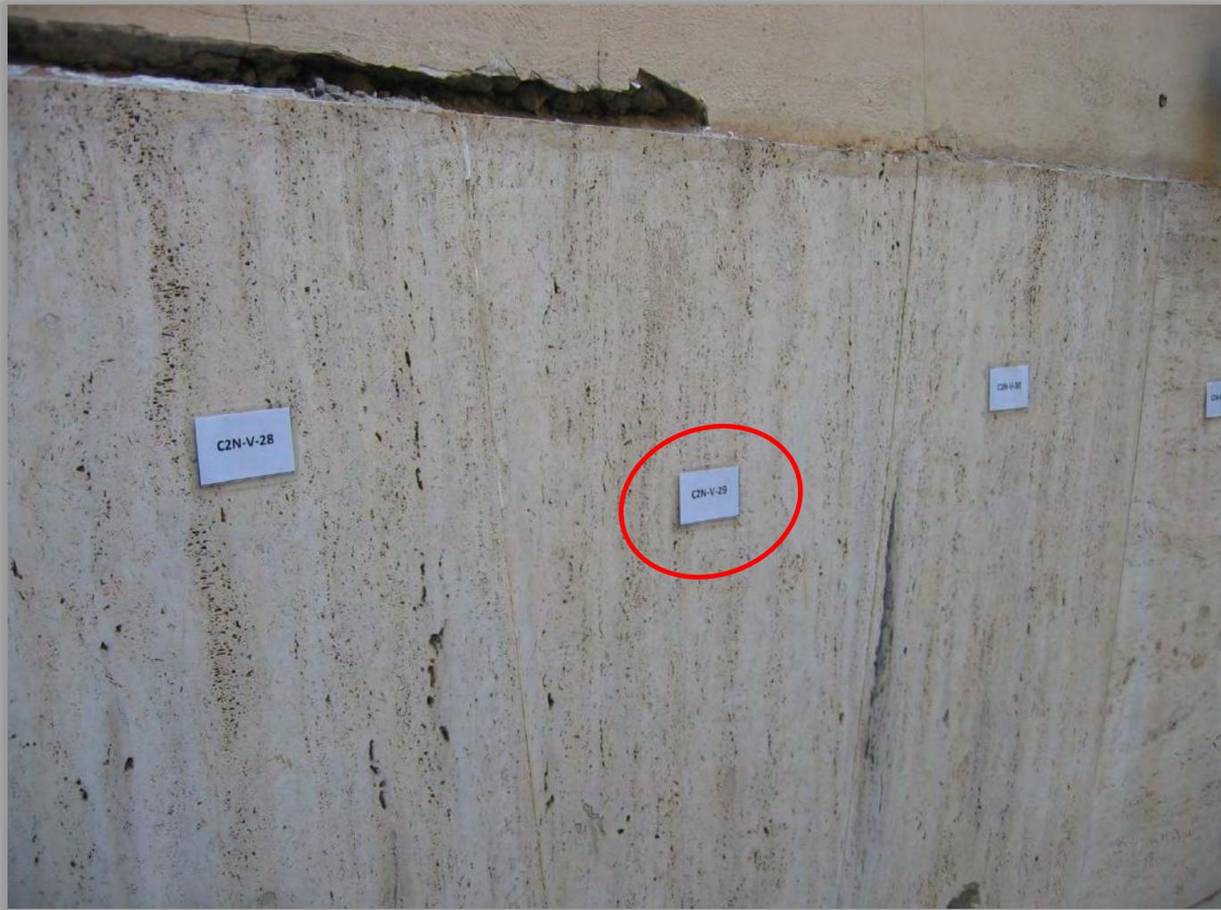
Le lastre del rivestimento vanno catalogate prima dello smontaggio
