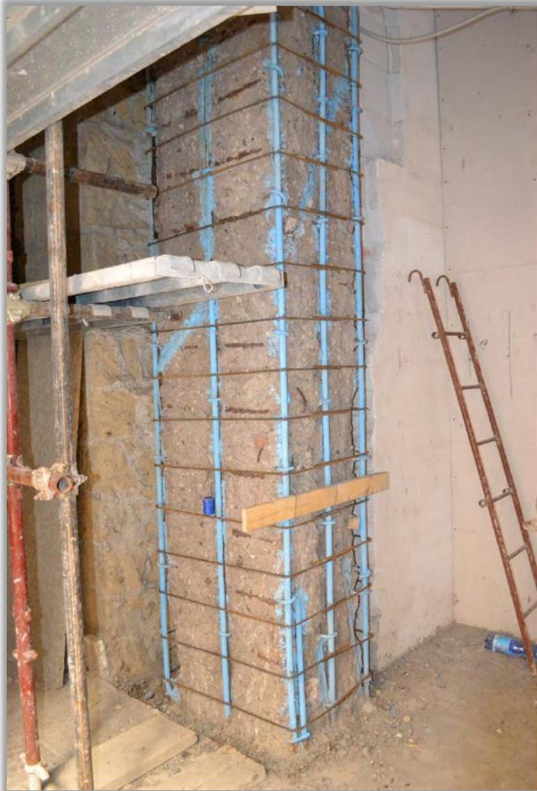
Il risanamento delle strutture, che ha richiesto la preventiva demolizione di tutte le compattature per metterle a nudo, è consistito nella rimozione del copriferro, nel trattamento anticorrosivo dei ferri, e nella ricostruzione del copriferro
