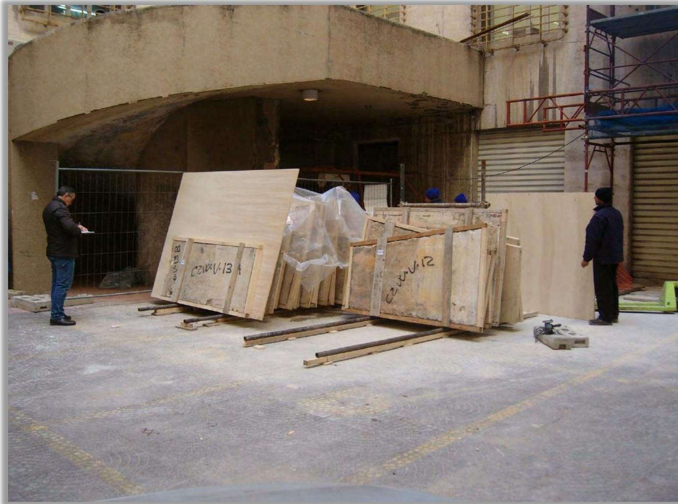
Le lastre vengono collocate a terra in una apposita area di stoccaggio, rilevate e fotografate
