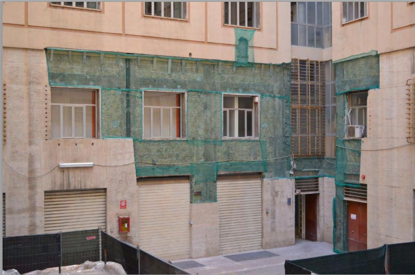
Al termine dei lavori la facciata viene protetta con reti saldamente fissate alla muratura
