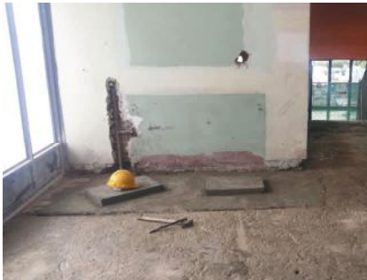
Formazione basamenti di appoggio
