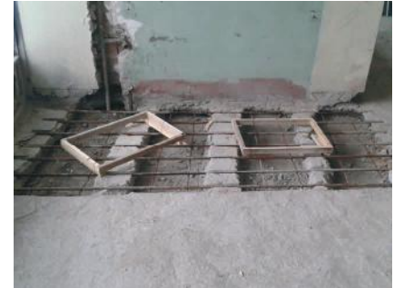
Rinforzo del solaio: estradosso
