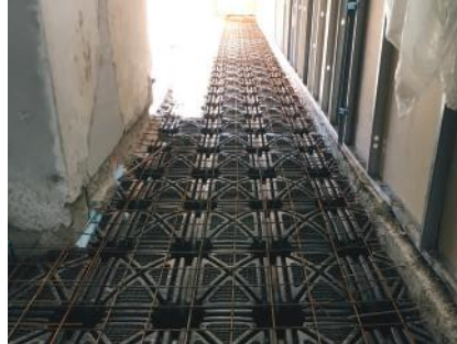
Costruzione del vespaio
