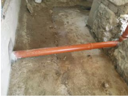
Sostituzione delle tubazioni pluviali
