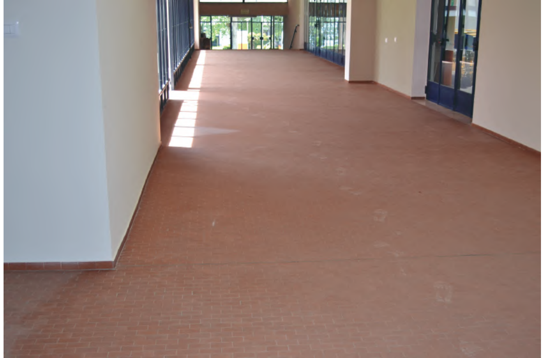
Interno del fabbricato G: corridoio principale allo stato attuale
