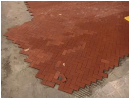
Posa della pavimentazione
