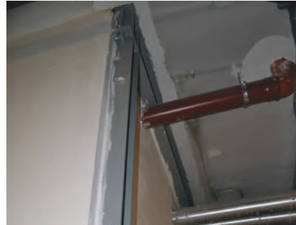
Rinforzo del solaio: intradosso
