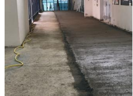
Formazione del massetto
