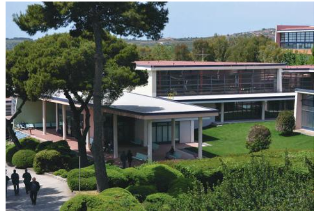
Il fabbricato G oggi
