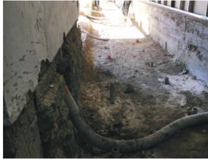
Consolidamento del terreno
